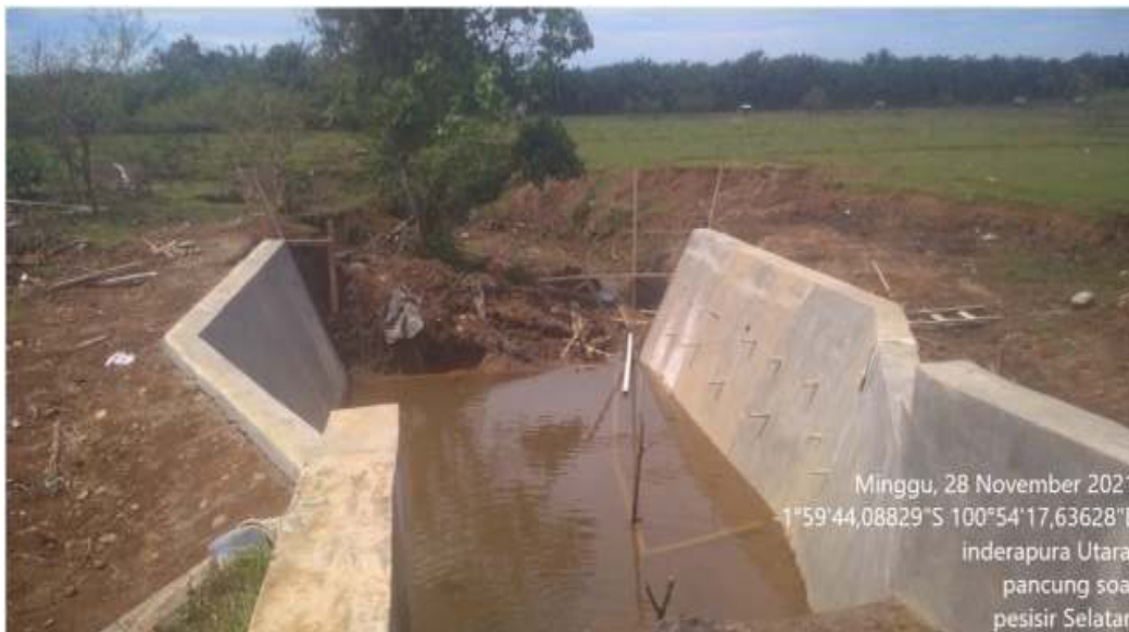
Gambar 3.13 : Perbaikan Sayap Bendung Daerah Irigasi (DI) Damar Rumpit
