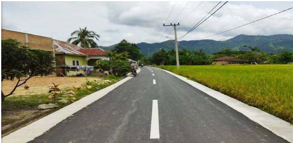
Gambar 3.8 : Peningkatan Jalan Simpang SMK – Bukit Batu Patah, Kec. Koto XI Tarusan Tahun 2021
