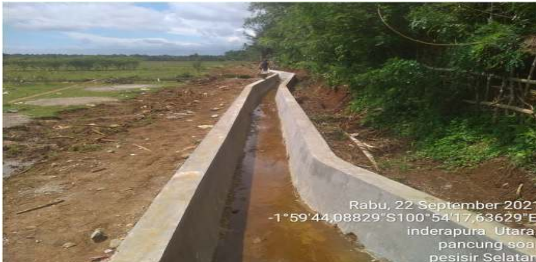
Gambar 3.14 : Rehabilitasi Saluran DI Damar Rumpit
