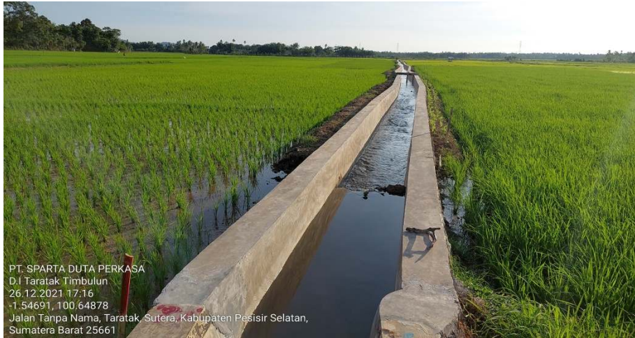
Gambar 3.9 : Bendung DI. Koto Panjang (2021 )
